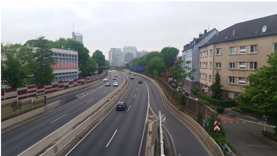
Abb. 1.1-1: Autobahn A 40 auf Essener Stadtgebiet
